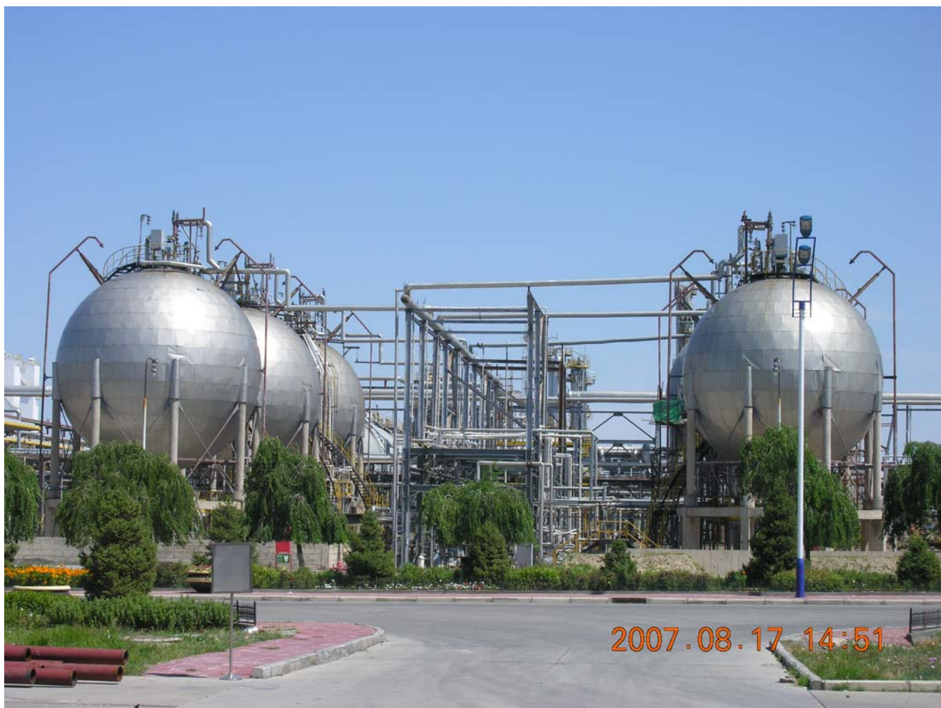
Теплоизоляция резервуаров с этиленом в Xinjiang
