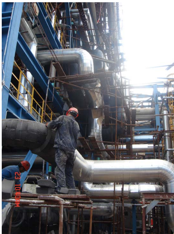
Теплоизоляция технологических трубопроводов завода по переработке нефти в Shandong
