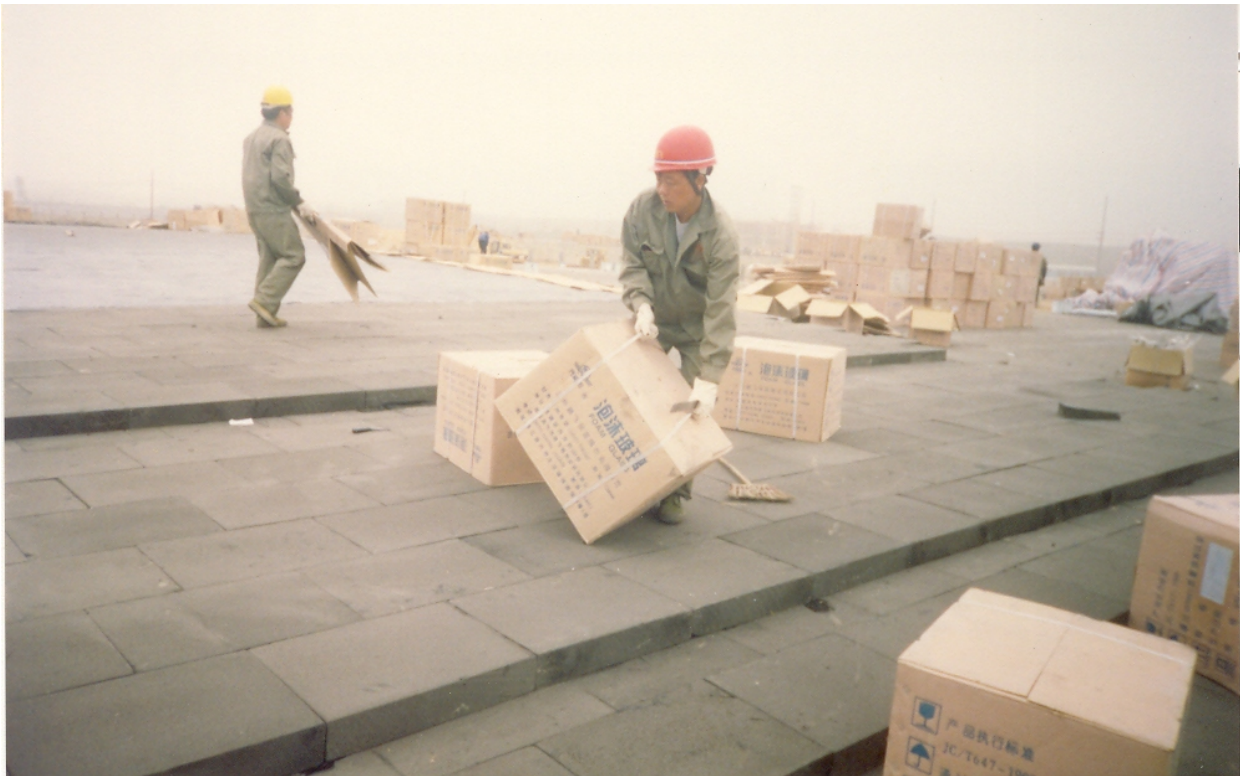
Теплоизоляция крыши резервуара сжиженного природного газа (LNG) в Guangdong
