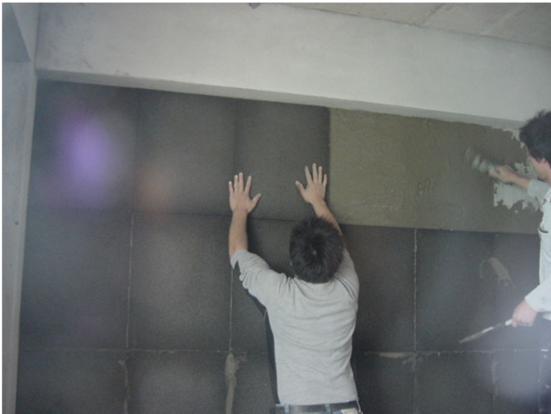
Теплоизоляция кровли и стен здания Шанхайского художественного центра
