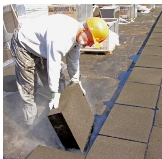
**Компактная кровля по бетонному основанию
