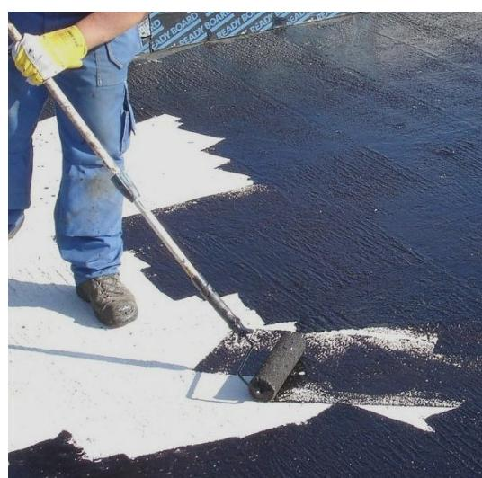
**Компактная кровля по бетонному основанию**
