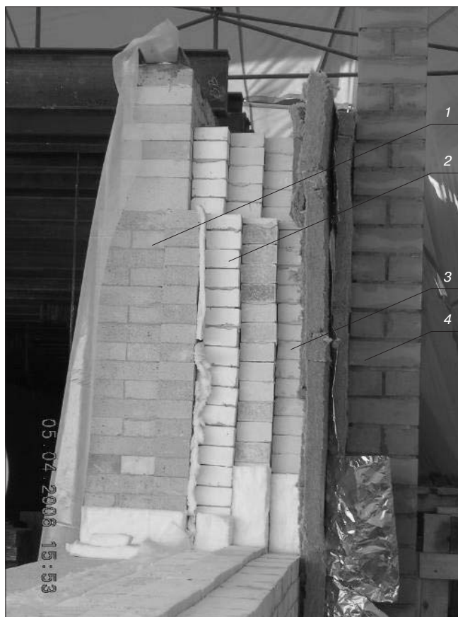
Рис. 3. Футеровка туннельной обжиговой печи кирпичного завода «Винербергер»: 1 – огнеупорный слой; 2 – слой легковесных огнеупоров; 3 – пенодиатомитовый кирпич КПД 400-И; 4 – облицовочный слой
