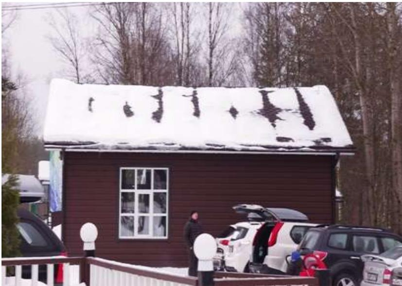
В кровле, где вата уложена между стропил, образуются «мосты» холода. Стропила прекрасно пропускают холод, т.к. теплопроводность дерева в 20 раз лучше, чем у эффективной теплоизоляции ПЕНОПЛЭКС®.
