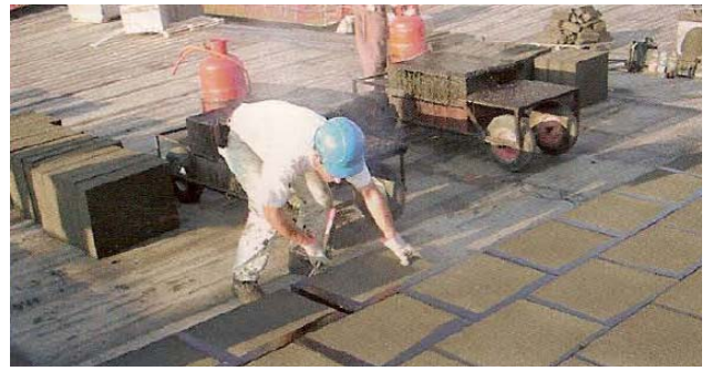
Рис. 10. Метод укладки плит по пароизоляционному слою
