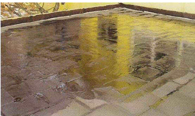
Рис. 13. Нанесение горячего битума по плитам
