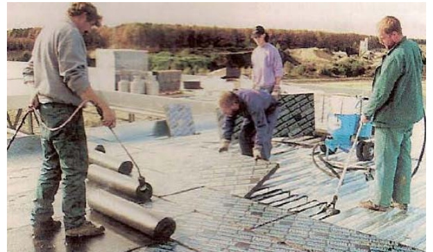
Рис. 11. Метод укладки плит по нанесенному полосами битуму
