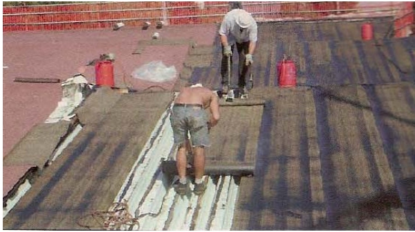
Рис. 10. Метод укладки плит по пароизоляционному слою
