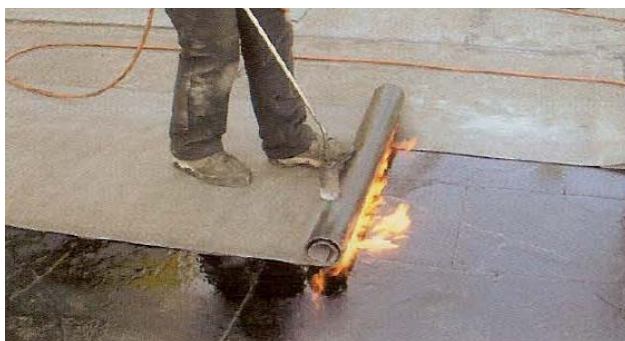
Рис. 14. Устройство подстилающего слоя из наплавляемого рулонного материала
