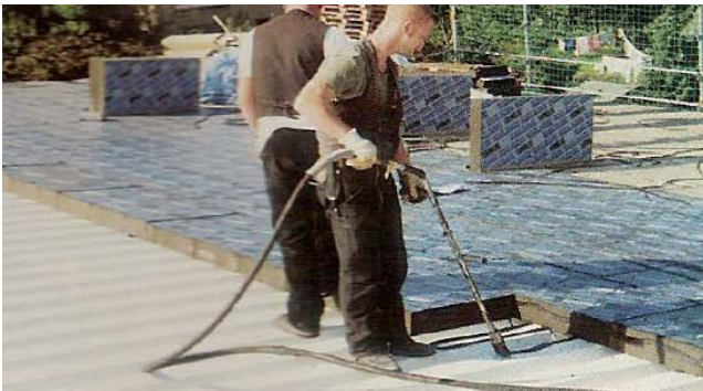
Рис. 11. Метод укладки плит по нанесенному полосами битуму
