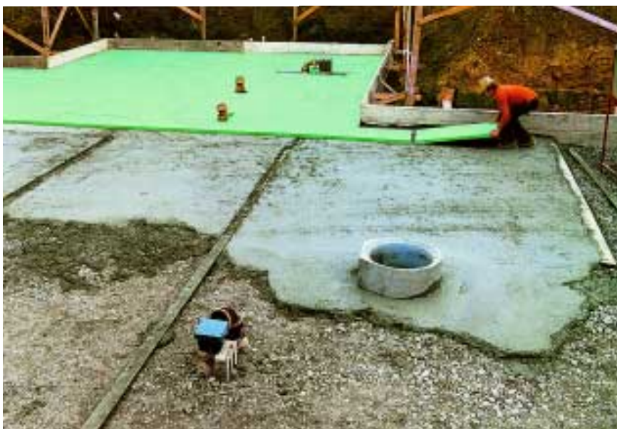
Рис. 10. Слой тощего бетона с ровной поверхностью для укладки теплоизоляции.
