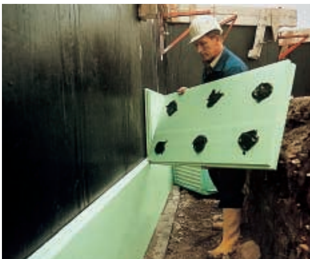
Рис. 3. Пример укладки плит Styrodur® С.
