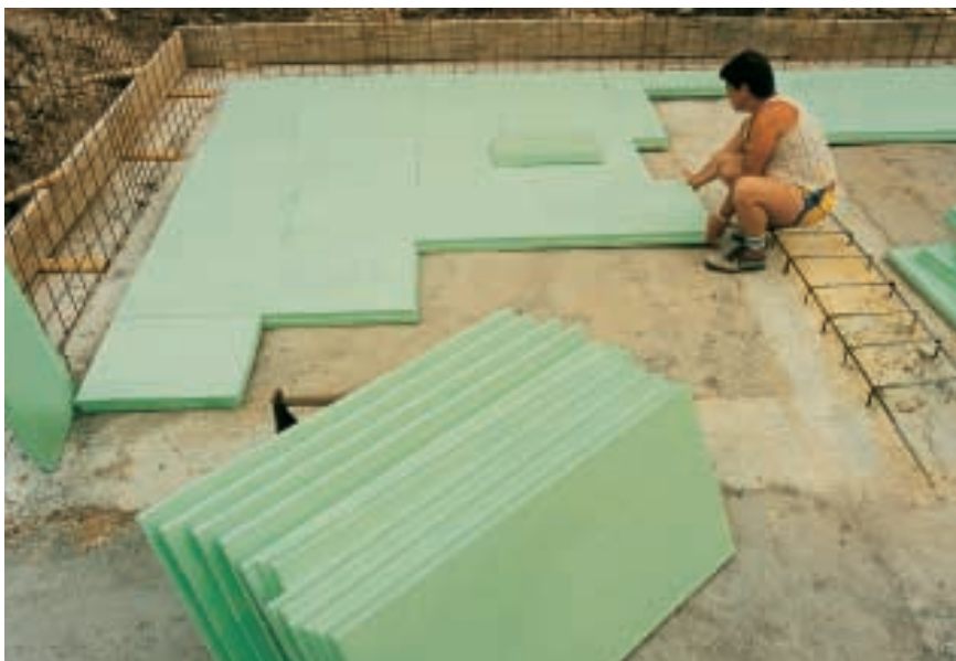
Рис. 11. Теплоизоляция пола плитами Styrodur® C на больших поверхностях.
