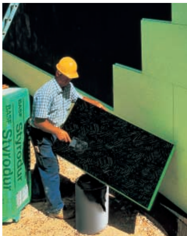
Рис. 22. Приклеивание плит Styrodur® С по всей поверхности в зоне грунтовых вод.
