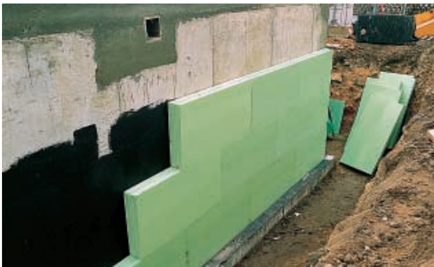
Рис. 3. Пример укладки плит Styrodur® С.
