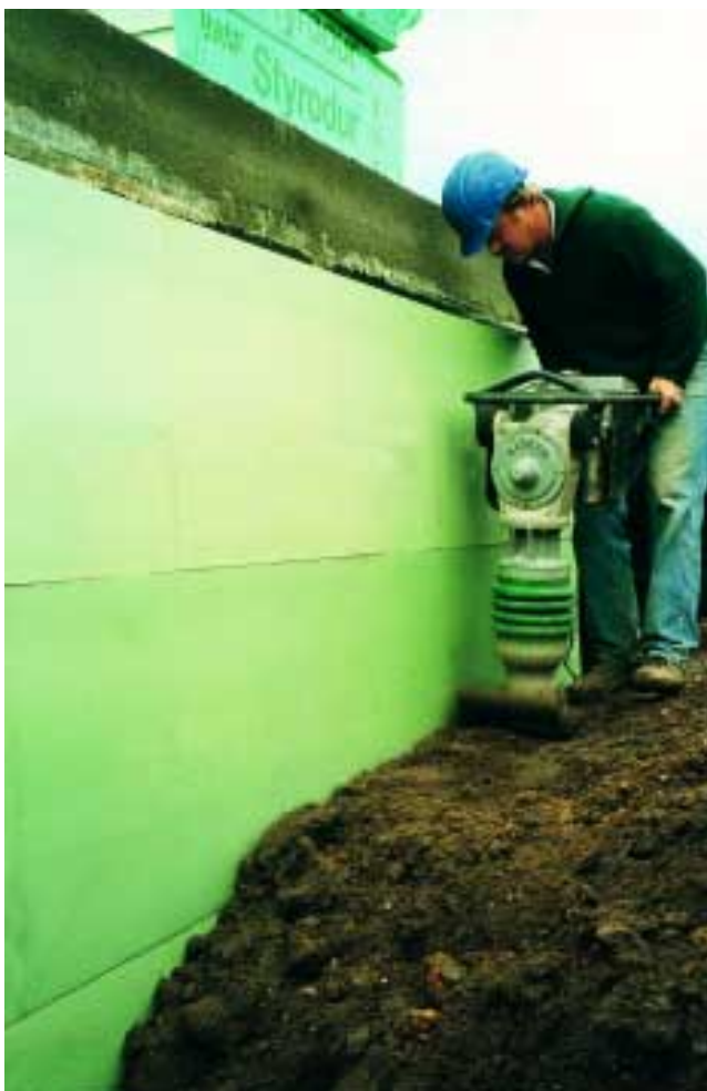
Рис. 23. Послойная балластировка строительного котлована и механическая утрамбовка.
