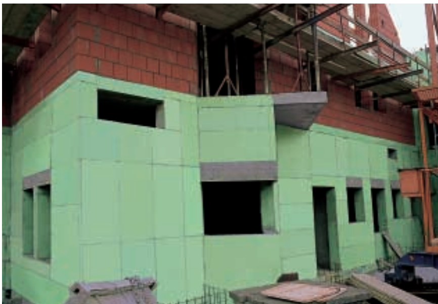
Рис. 25. Теплоизоляция больших поверхностей первого этажа здания плитами Styrodur® C.
