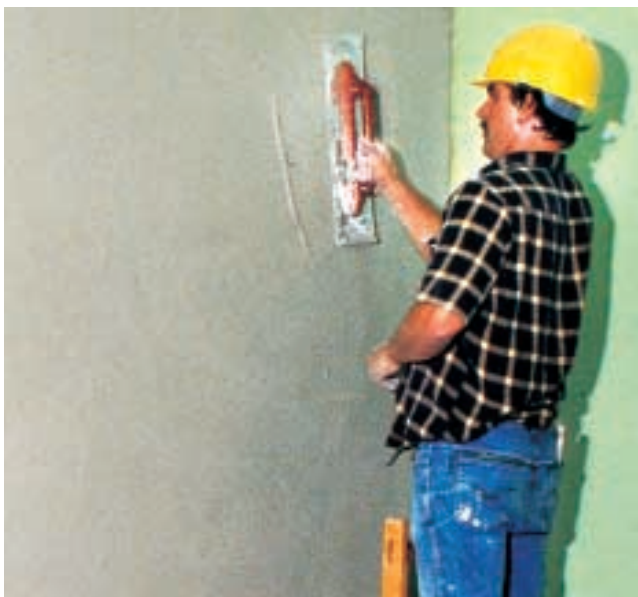
Рис. 36. Нанесение второго слоя штукатурки толщиной около 5 мм. Наложение штукатурки осуществляется “по сырому”.
