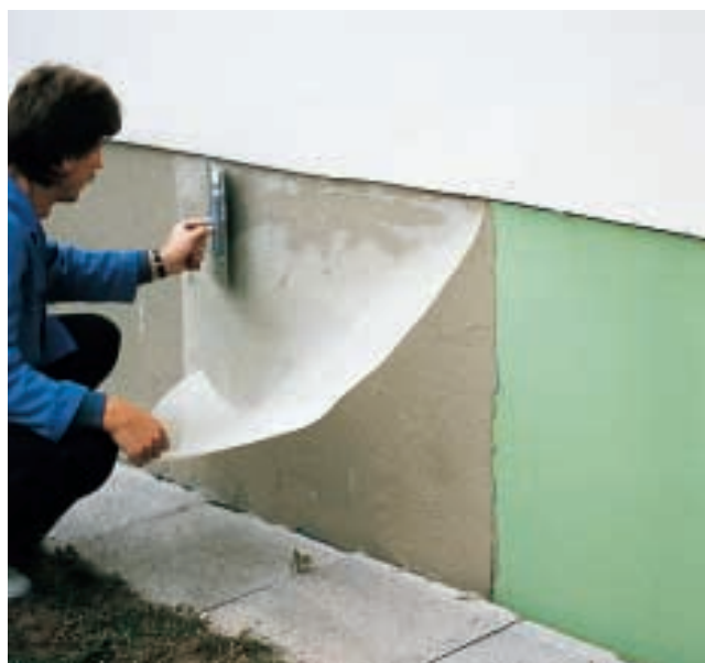
Рис. 31. Укладка решетчатой ткани из стекловолокна на грунтовый слой штукатурки цокольной изоляции.
