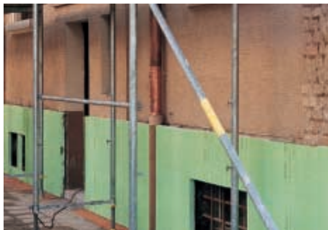
Рис. 15. Дополнительная теплоизоляция цоколя с применением плит Styrodur® 2800CS.
