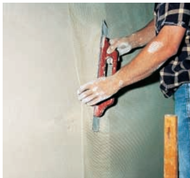
Рис. 36. Нанесение второго слоя штукатурки толщиной около 5 мм. Наложение штукатурки осуществляется “по сырому”.
