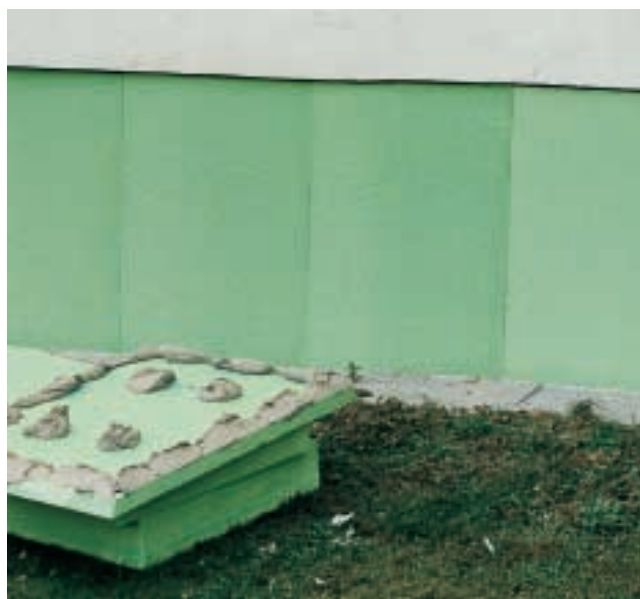
Рис. 33. Ремонт старых зданий. Наклеивание плит Styrodur® 2800CS точечным способом по швам.
