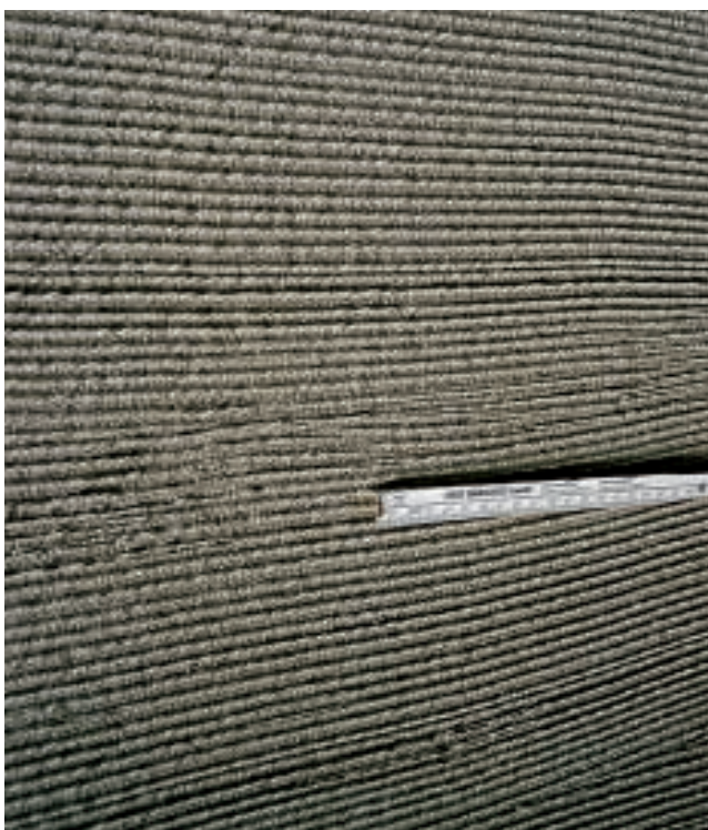
Рис. 25. Теплоизоляция больших поверхностей первого этажа здания плитами Styrodur® C.
