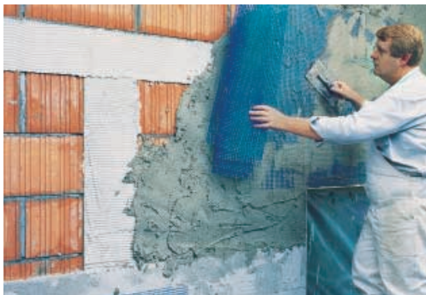
Рис. 24. Нанесение нижнего слоя штукатурки и наложение армирующей стекловолоконной сетки на теплоизолируемые бетонные строительные элементы.
