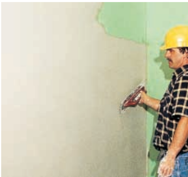
Рис. 35. Укладка на всю поверхность решетчатой арматурной ткани из стекловолокна. Полосы ткани укладывают с нахлестом 100 мм.
