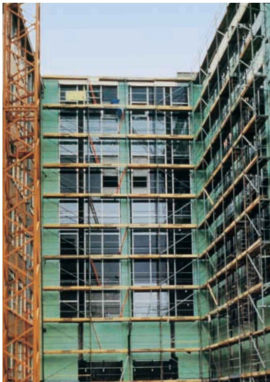
Рис. 5. Теплоизоляция мостиков холода с помощью Styrodur® 2800CS.
