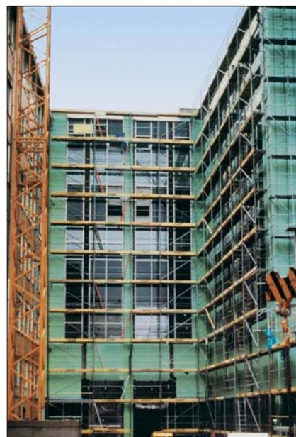
Рис. 4. Теплоизоляция мостиков холода с помощью Styrodur® 2800CS
