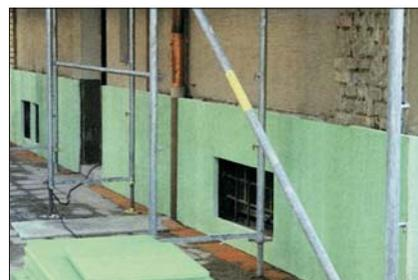
Рис. 6. Цоколь здания, утепленный материалом Styrodur®
